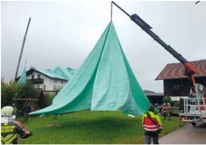
Fotos: A. Guggemos, ein Notdach wird vorbereitet. Von 400 Dächern im Ort sind 380 beschädigt
